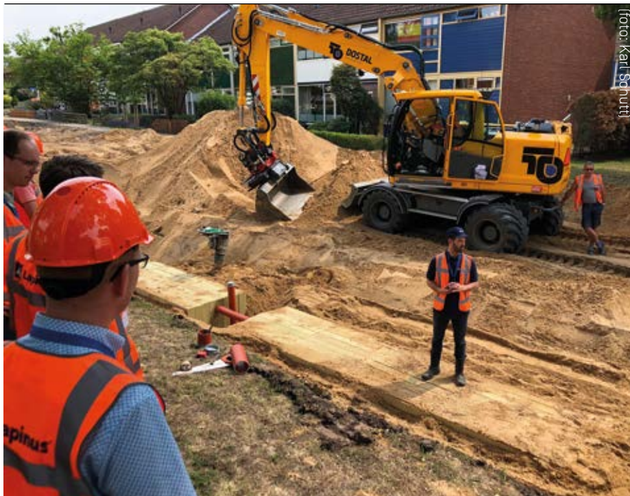
Aanbrengen van het systeem in Groessen.
